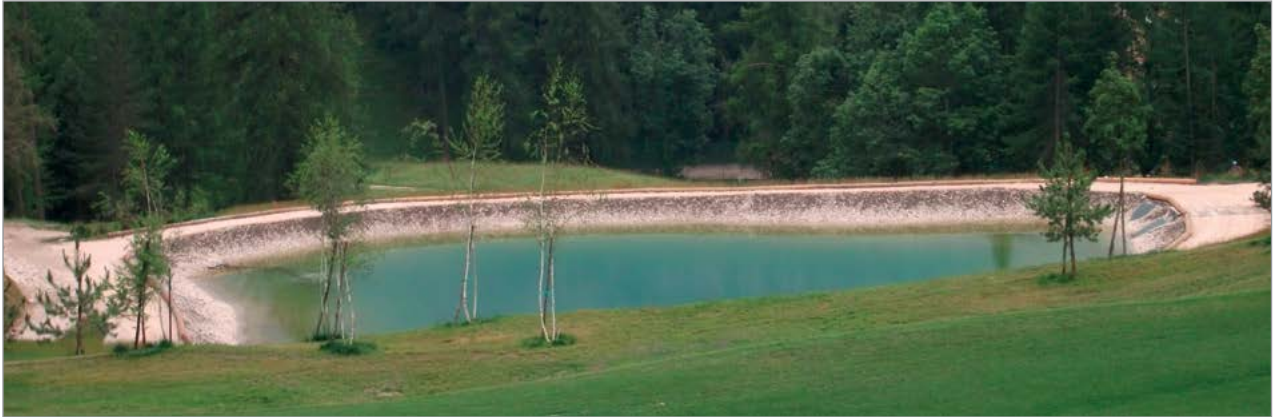
Vista d'insieme a lavori ultimati
