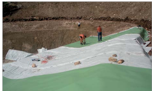
Posa geocomposito drenante Pozidrain
