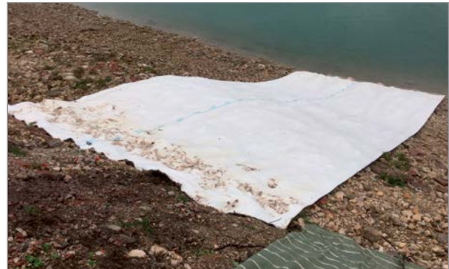
Posa del Tektoseal Sand riempito di sabbia
