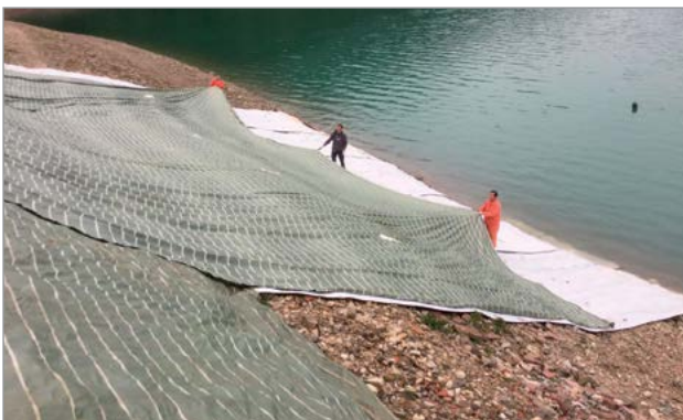
Posa dell'Incomat Crib 10.100
