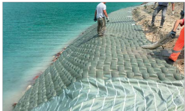
Riempimento dell'Incomat 10.100 con miscela cementizia
