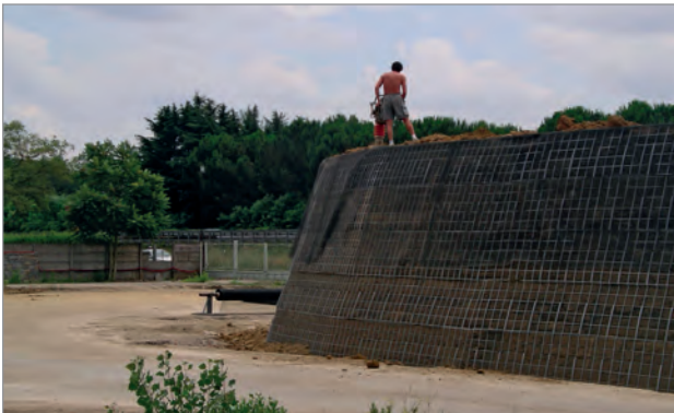
Realizzazione ultimo strato
