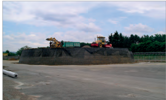
Fase di compattazione terreno di riempimento
