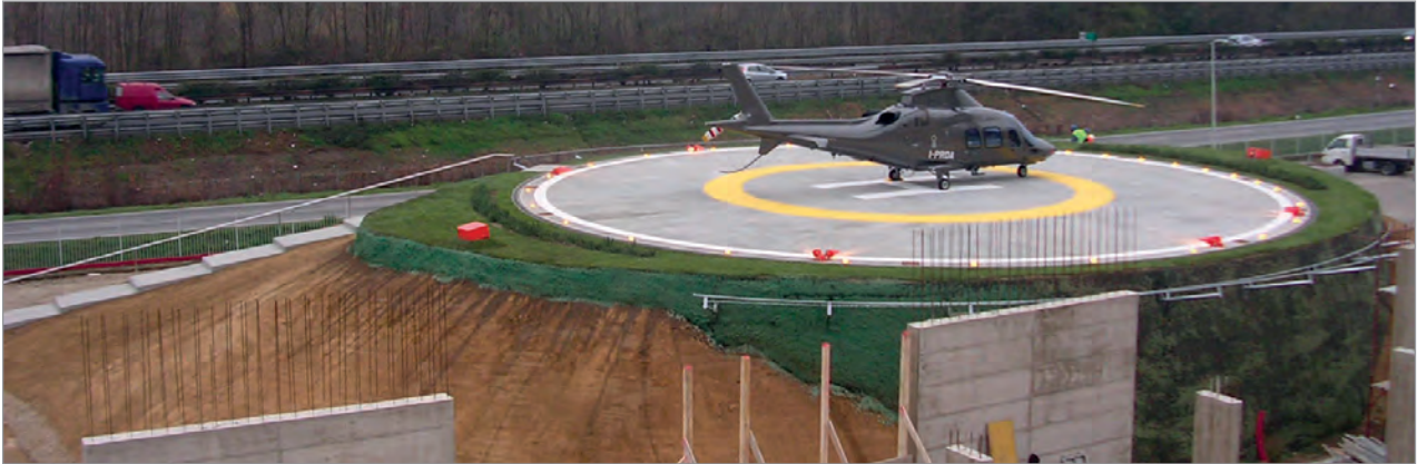
Terre rinforzate per la realizzazione di un eliporto
