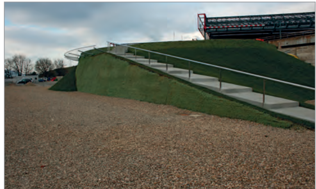
Eliporto dopo idrosemina e realizzazione scale d'accesso
