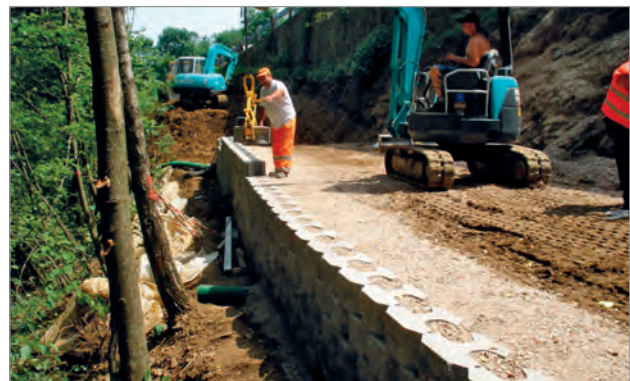
Fasi di realizzazione del muro
