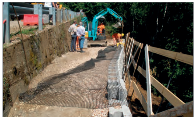
Fasi di realizzazione del muro
