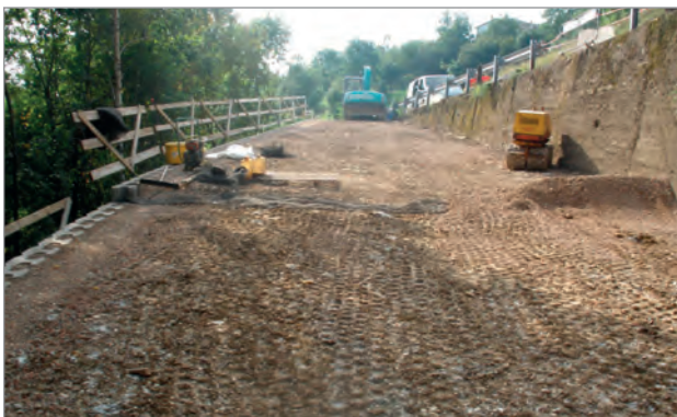
Fasi di realizzazione del muro
