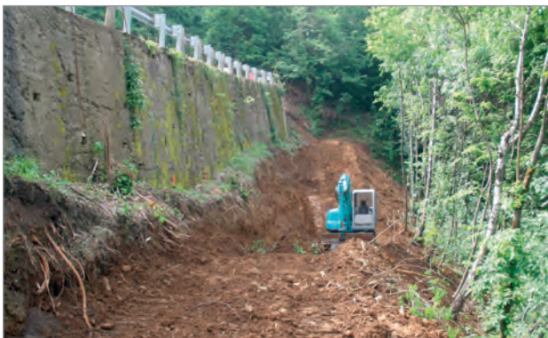
Fasi di scavo per l'imposta del muro
