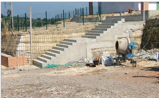
Realizzazione scale in c.a. a ridosso delle terre rinforzate
