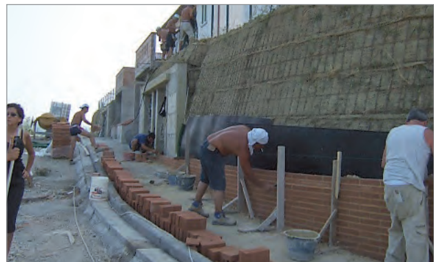
Rivestimento della parte realizzata con Stablenka
