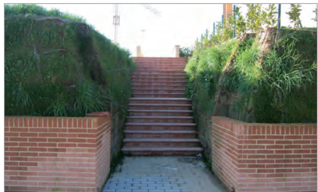
Rivestimento scale e rinverdimento terre rinforzate
