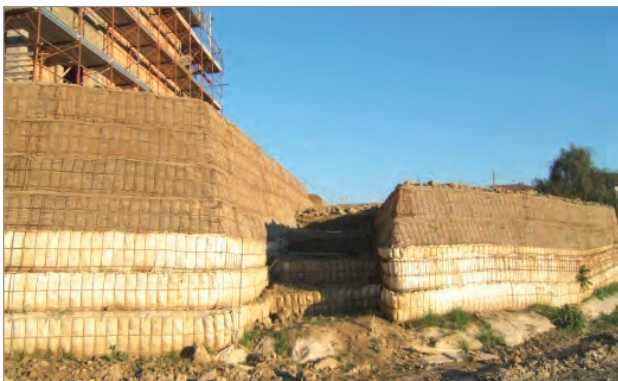
Vista a opera appena terminata
