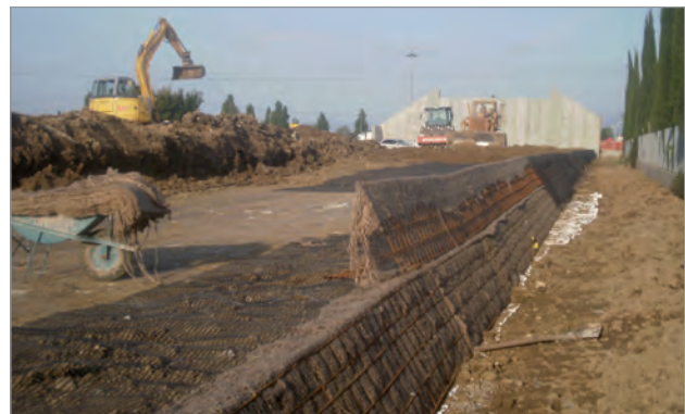
Fasi di posa Fortrac® 110 T
