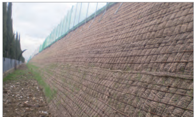
Particolare rilevato stradale realizzato
