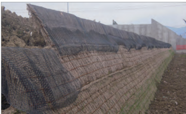
Particolare realizzazione 5° strato
