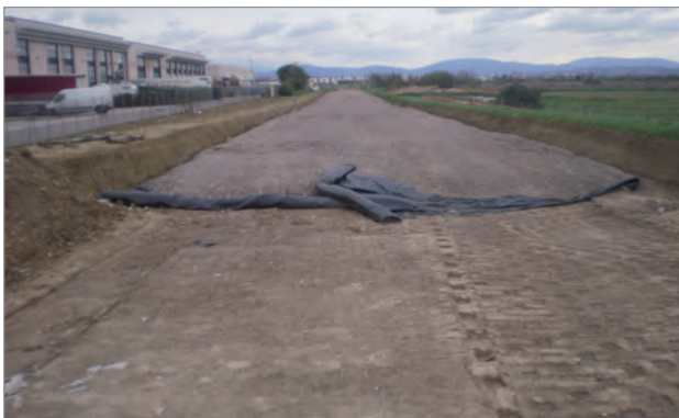
Fasi di posa Hate 6G/185/SA
