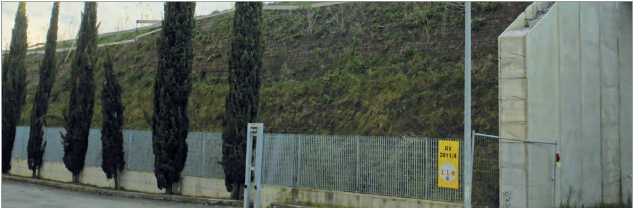
Terre rinforzate di raccordo con sottopasso stradale
