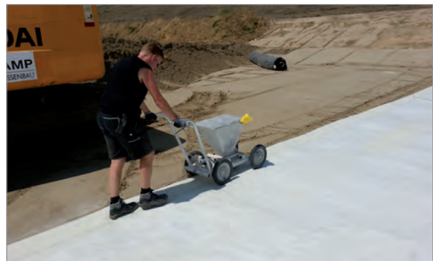
Posa della bentonite in polvere sui sormonti
