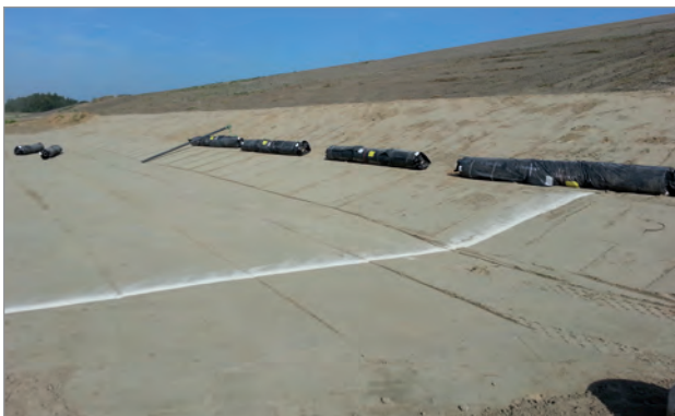
Preparazione del sottofondo
