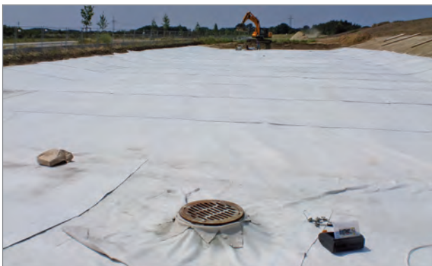
Connessione del Tektoseal® 5000 con lo scarico
