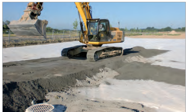
Posa del terreno di copertura mediante un escavatore
