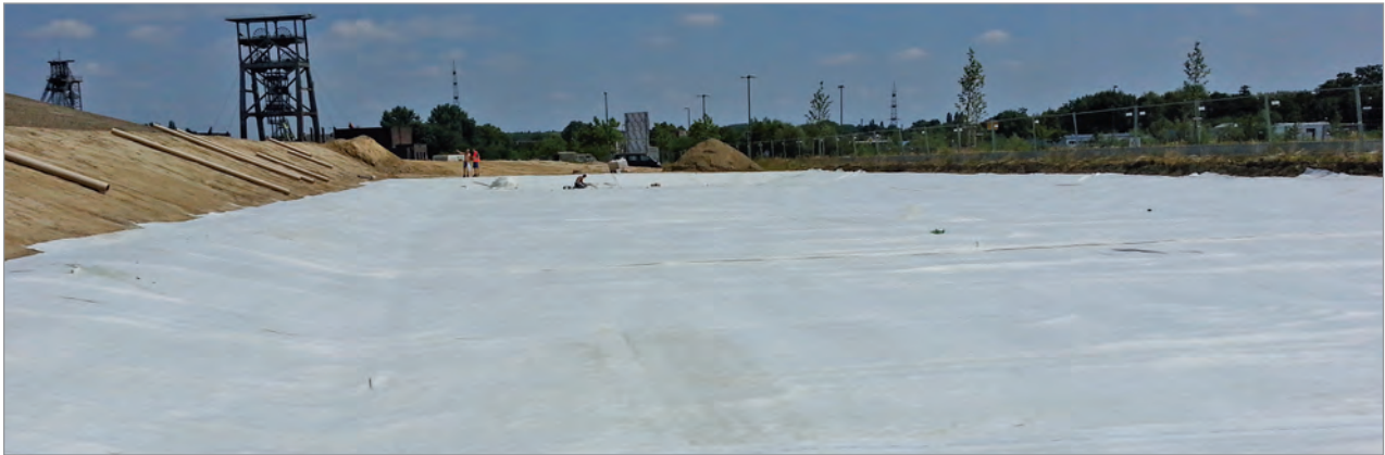
Bacino di accumulo acqua piovana presso la vecchia miniera di carbone di Gneisenau (Germania) impermeabilizzato con il Tektoseal® 5000
