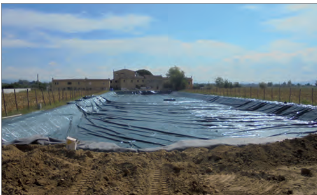
Impermeabilizzazione completata
