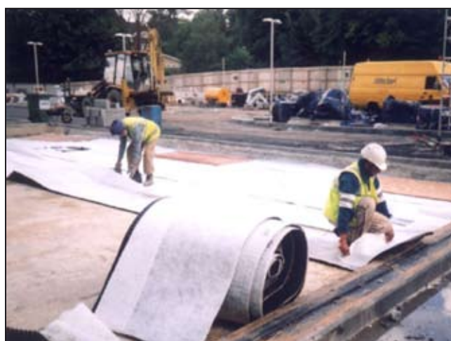
Posa in orizzontale del Deckdrain®
